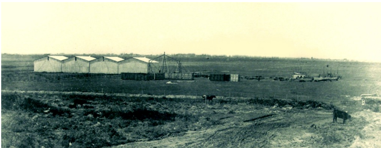
Vista de los cuatro hangares en construidos en Villa Lugano. La fotografía está tomada en marzo de 1910 prácticamente desde la esquina de Av. Coronel Roca y Tellier (Foto Archivo General de la Nación)
